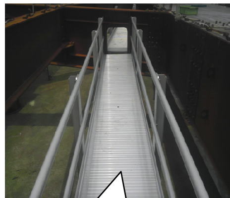
歩廊面には滑り止め凹凸付
