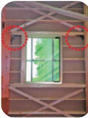
BOSHIN(ボウシン)設置完了。
