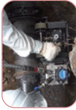
切断する鉄管 (直径20cm)
