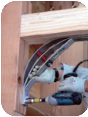
M-12 90mm~100mmのコーチスクリューボルト4本でBOSHIN(ボウシン)を縫い設置。
