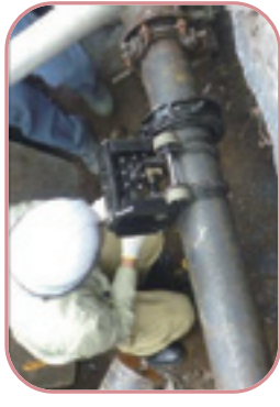
高速切断機の設置
