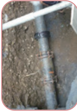
切断する鉄管 (直径20cm)
