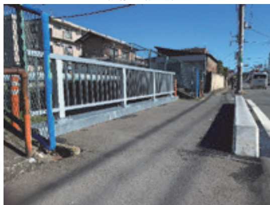
補修・補強後
