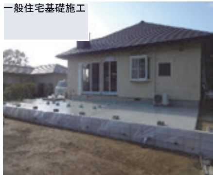
一般住宅基礎施工
