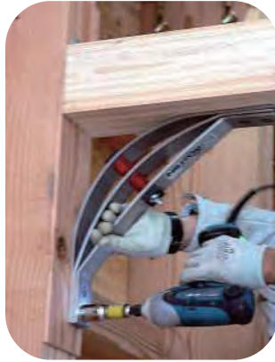
M-12 90mm~100mmのコーナースクリューボルト4本でBOSHIN(ボウシン)を縫い設置。
