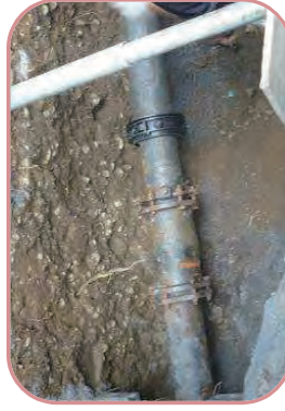
切断する铸铁管（直径20cm）
