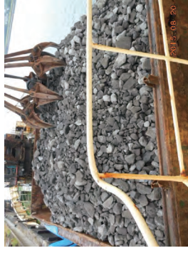
人工石施工状況
