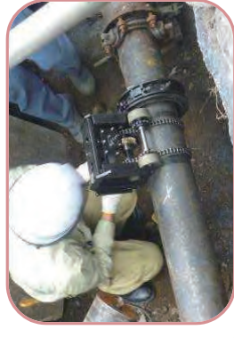
高速切断機の設置
