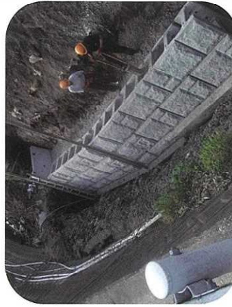
景観タイプ設置・胴込砕石充填状況
