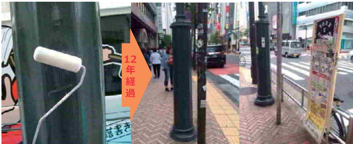
(2004年4月施工) 商店街振興組合が管理する、街灯支柱にコーティング施工 (2016年4月現在) 他の道路付属物と対照的に、落書き・ステッカー等が無く、また塗装の劣化、腐食(サビ)も起きていない様子が判る
