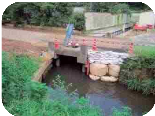
既設橋梁更新前
