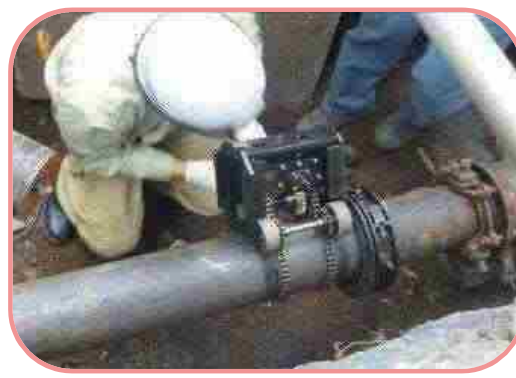
高速切断機の設置
