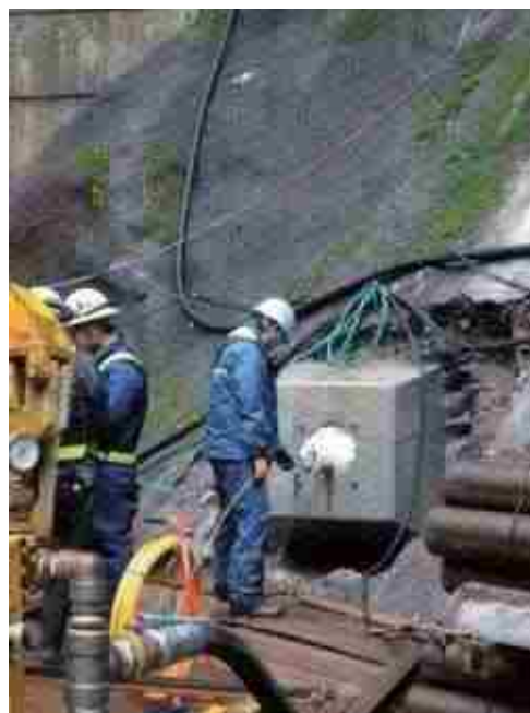
グラウンドアンカー用管路測定状況
