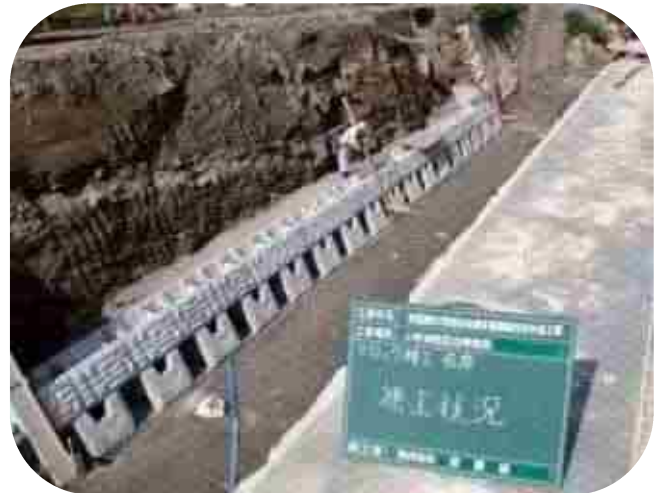
ブロック設置状況
