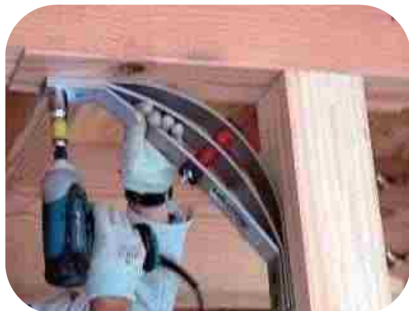
M-12 90m~100mmのコーチスクリューボルト4本でBOSHIN(ボウシン)を縫い設置。
