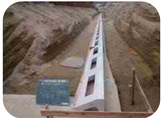
胴込めコンクリート打設後完成
