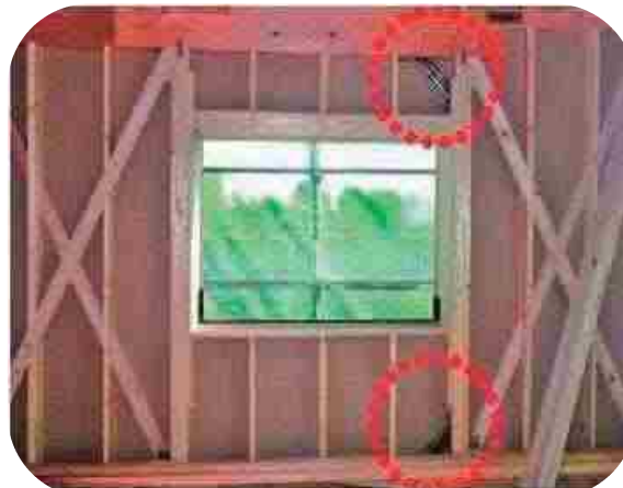
BOSHIN(ボウシン)設置完了。
