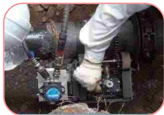
管の外周に沿って高速切断機を1周させる
