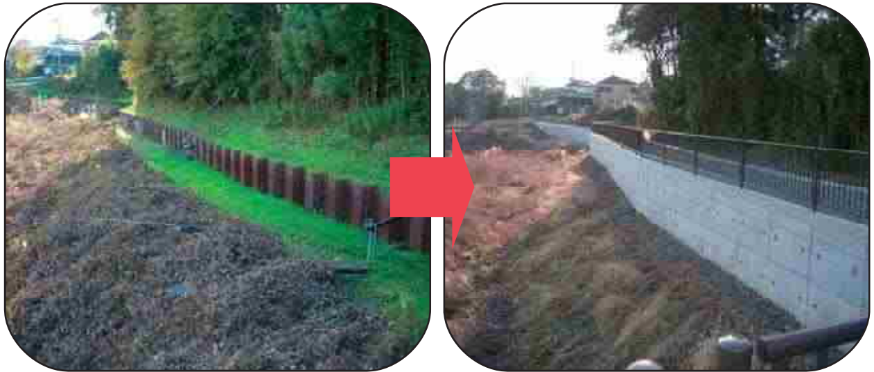
技術（製品）の施工状況
