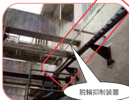
<脱輪抑制装置取付後>
