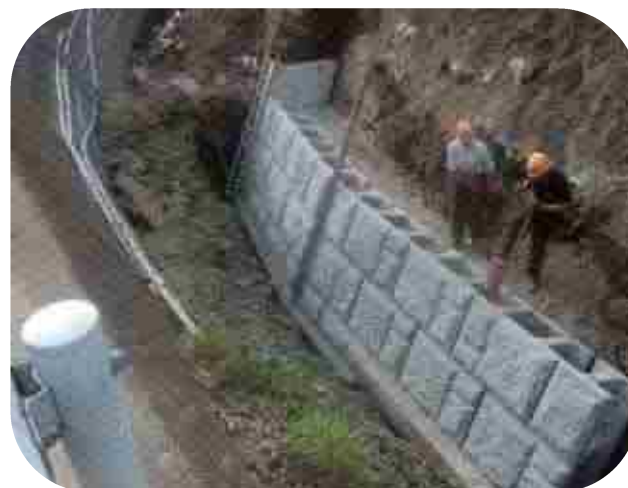
景観タイプ設置・胴込砕石充填状況
