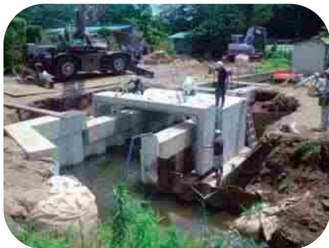
製品設置状況
