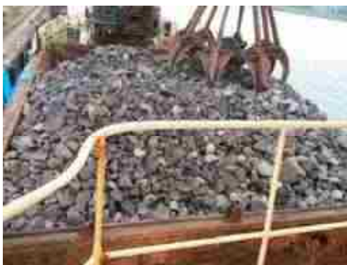
人工石施工状況
