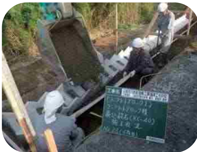
ブロック積上げ後、裏込め砕石施工
