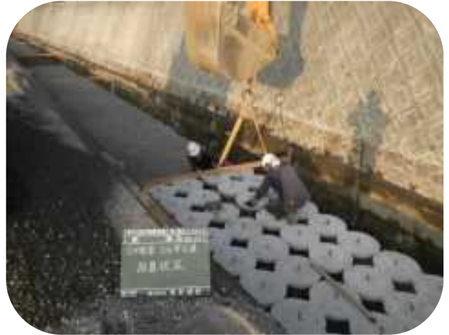
コマ型ブロック設置状況
