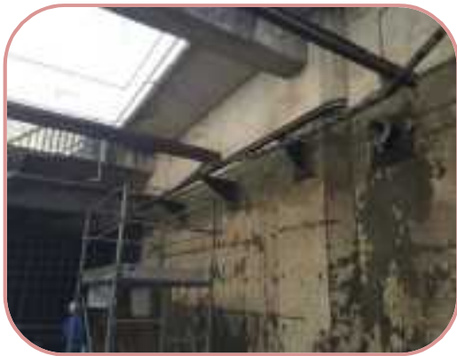
<脱輪抑制装置取付前>
