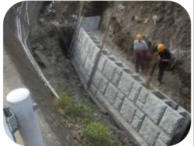
景観タイプ設置・胴込砕石充填状況
