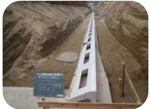
胴込めコンクリート打設後完成
