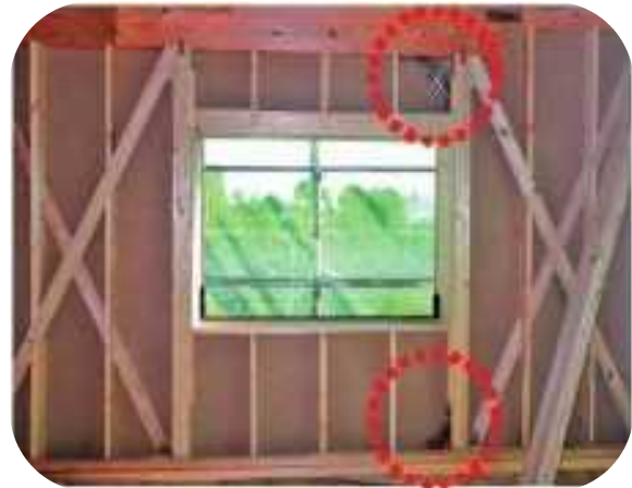
BOSHIN(ボウシン)設置完了。
