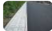
アーツ施工後
