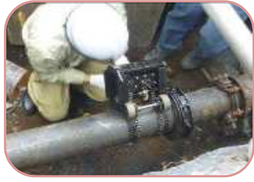
高速切断機の設定
