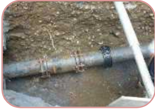
切断する铸铁管（直径20cm）
