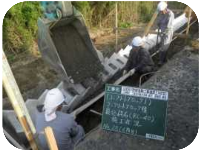
ブロック積上げ後、裏込め碎石施工
