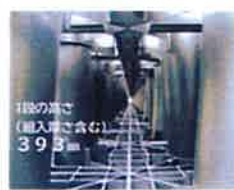
貯留槽内部の構造
