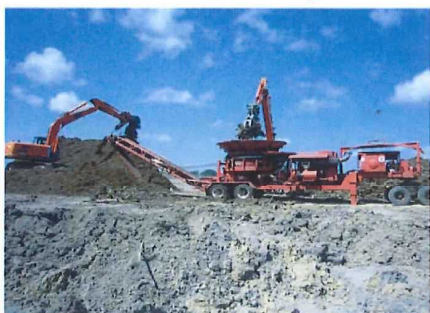
2インチスクリーンによる現場内破碎 場外搬出をせず、コスト縮減
