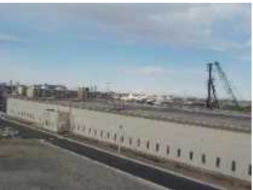
③水処理第1系列全景
