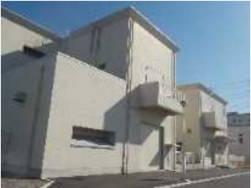
②主ポンプ棟全景
