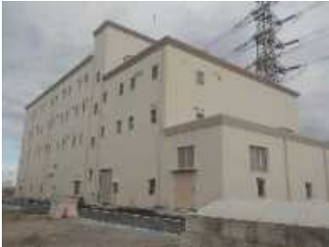
①汚泥処理棟全景
