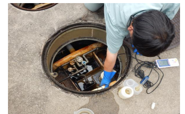
合併処理浄化槽の検査状況
