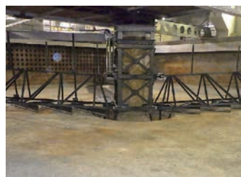
水処理設備の更新
