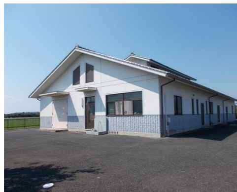
東金市 うわや 上谷クリーンセンター (農業集落排水)
