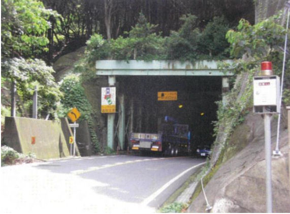
実入トンネルの車両通行状況
