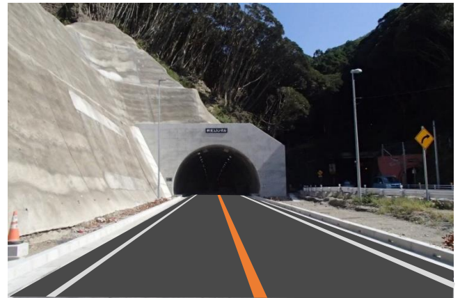
新実入トンネルの入口付近（鴨川側）
