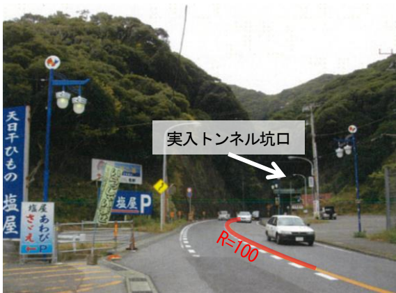
実入トンネルの入口付近（鴨川側）
