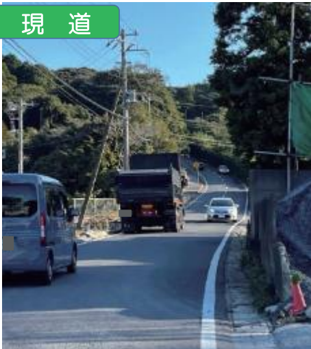
幅員が狭く、見通しが悪い現道
