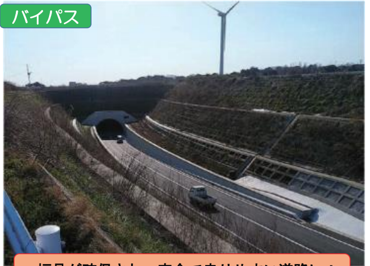
幅員が確保され、安全で走りやすい道路に！
