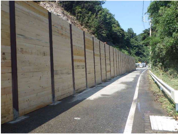
応急作業完了後
