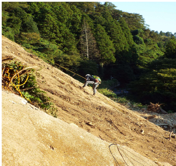
弾性波探査状況
