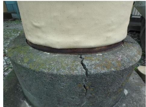
鉄筋の腐食により、ひびわれが発生している。
