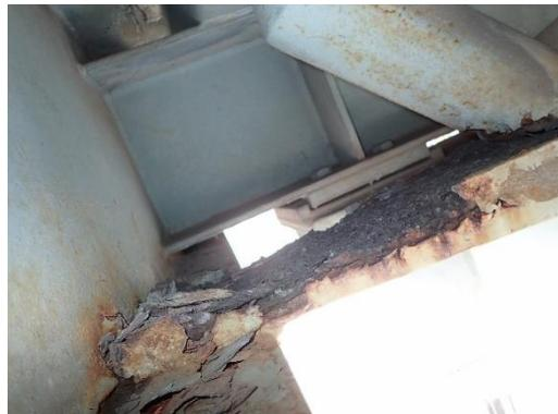
排水桶に腐食が生じている。
