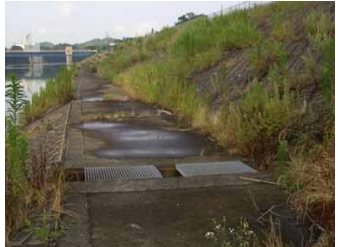
被害：グレーチングの盗難 新たな設置に無駄な費用を要す
