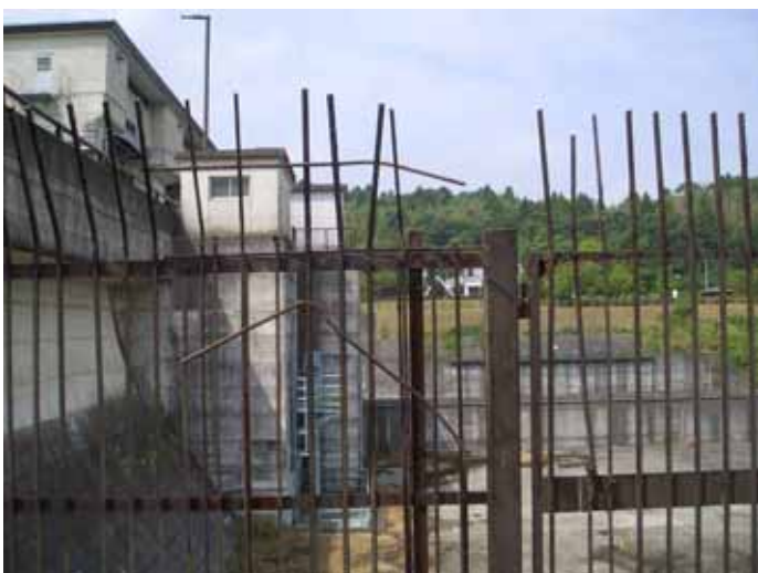
被害：立入防止柵を壊された 無駄な補修費を費やすこととなる
