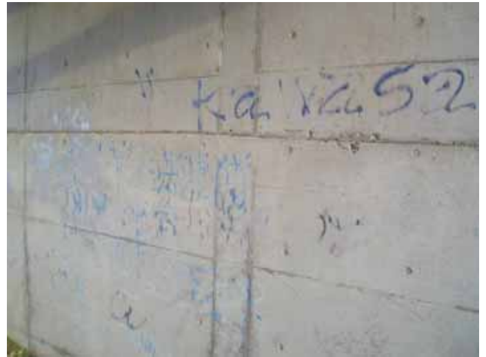
被害：施設へ落書き 努力をしても消しきれない
