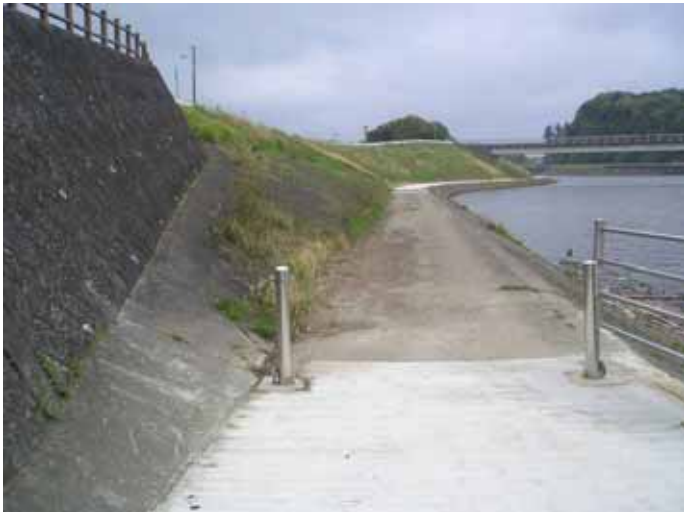
被害：立入禁止チェーンの盗難 新たな設置に無駄な費用を要す
