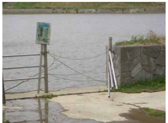
被害：転落防止柵を壊された 無駄な補修費を費やすこととなる
