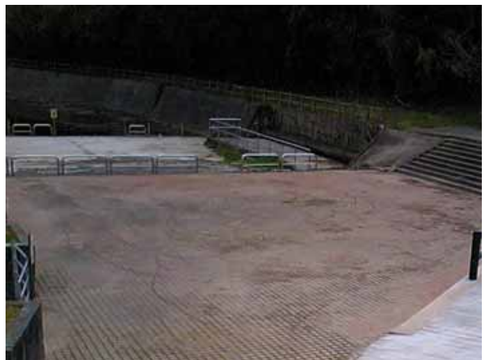
被害：公園内での二輪車の乗り回し 車両進入防止柵の隙間から入られた
