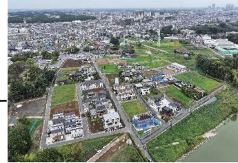
野々下周辺工事状況
