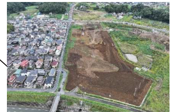
305-2街区周辺工事状況
