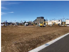
115街区周辺工事状況
