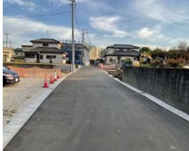
71街区周辺工事状況
