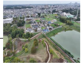
総合運動公園工事状況
