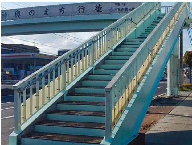
主要地方道 東京市川線 相之川歩道橋補修
