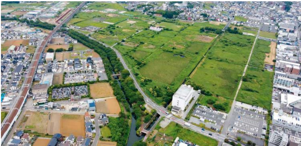
二級河川 海老川水系 海老川 広域河川改修事業
