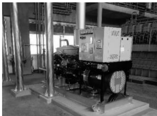
西浦排水機場自家発電設備更新
