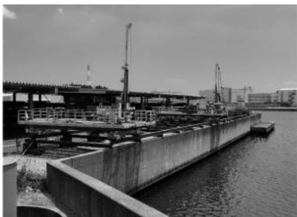
栄高潮護岸海上地盤改良工
