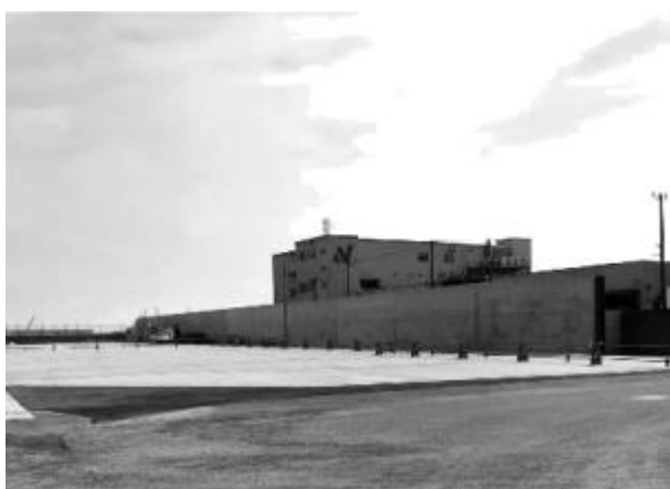
日の出荷捌地舗装工
