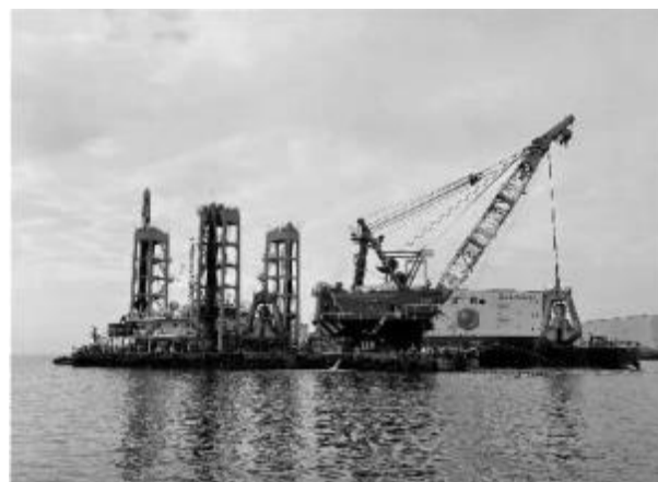
市川泊地浚渫工
