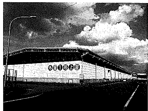
外貿1号上屋耐震改修
