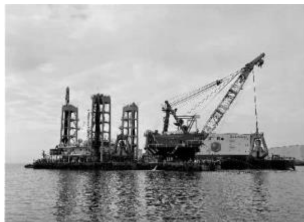
市川泊地浚渫工
