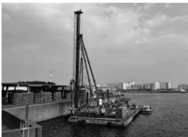
栄高潮護岸海上地盤改良工
