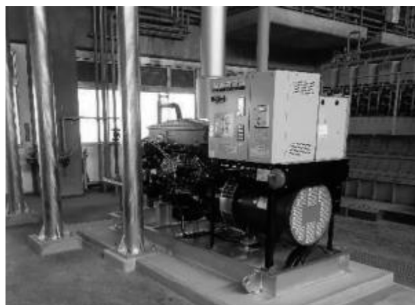
西浦排水機場自家発電設備更新
