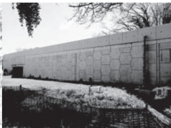
令和6年度施工 擁壁工
