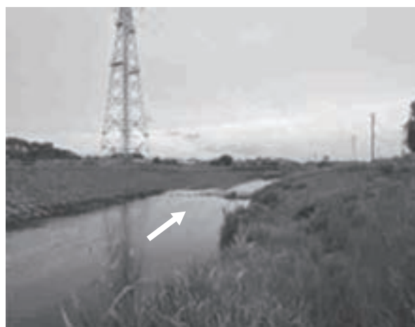
令和3年度完成 護岸工 L=50m(左岸)
