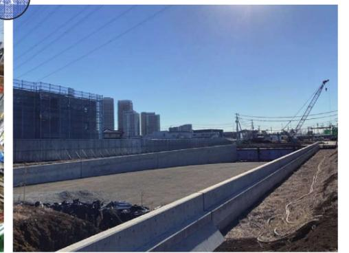
事業区内で最大規模の工事となる、国道16号と都市軸道路との立体交差部（アンダーパス）の現場写真（写真左）と、完成した擁壁（アンダーパス入口部分：写真右）です。
