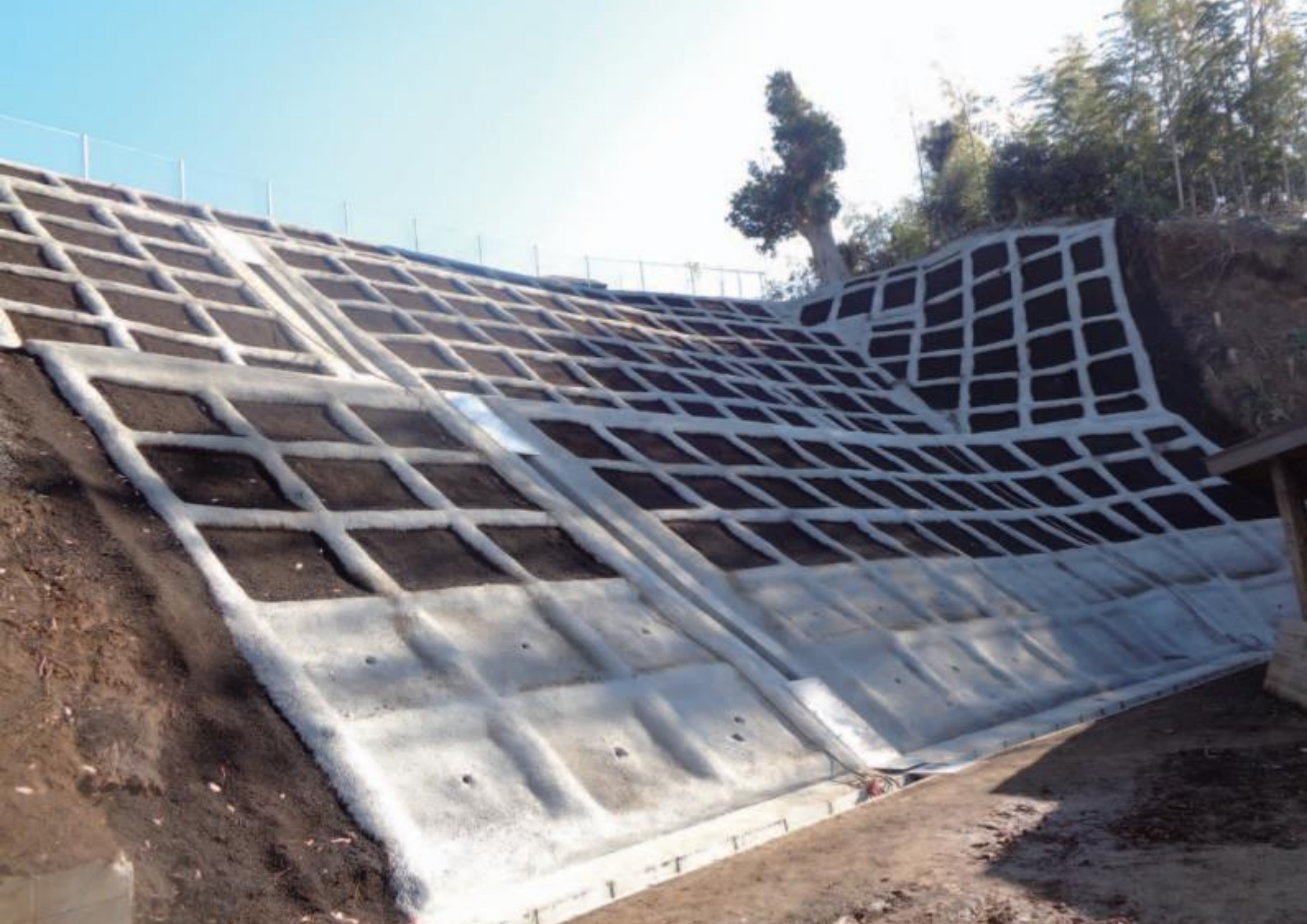
急傾斜地崩壊危険区域(長作町13)
