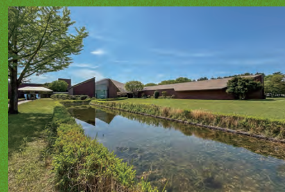
千葉県立美術館展示棟 国登録有形文化財（建造物）
