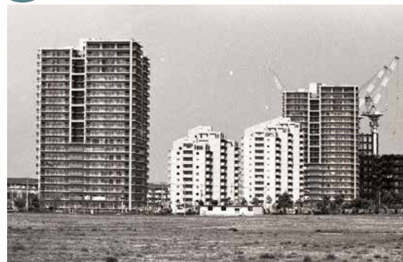
千葉ニュータウン(印西市)工事の様子 / 千葉県立中央博物館
