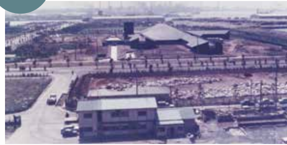
建設中の県立美術館 / 千葉県立美術館
