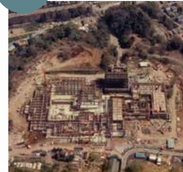
建設中の写真 / 国立歴史民俗博物館
