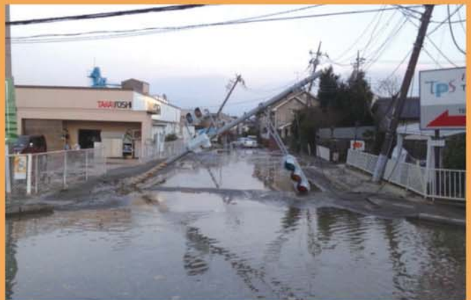
泥水が噴出し電柱が傾く（我孫子市布佐）
