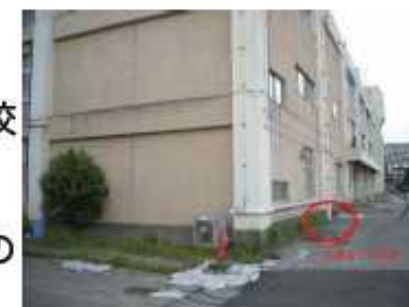
入船南小学校 (PHC、地盤改良有り)
