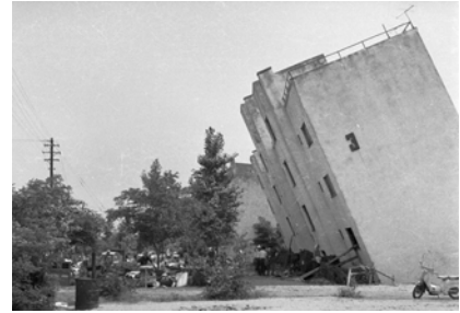
67. 新潟地震で液状化により傾いたアパート
