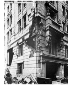
37. 地震で破壊した日本郵船ビル 写真提供：国立科学博物館
