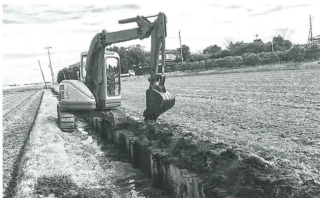
写真2 排水路の泥上げ作業の様子
