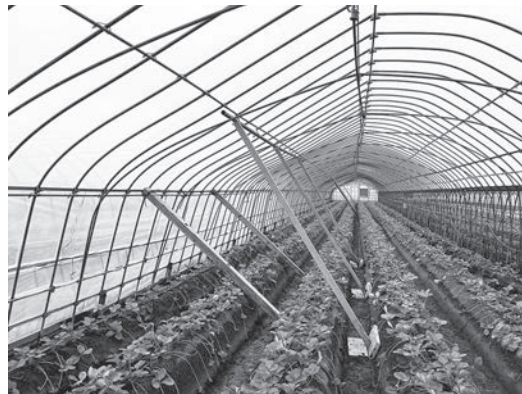
ハウス内から支柱で補強している事例
