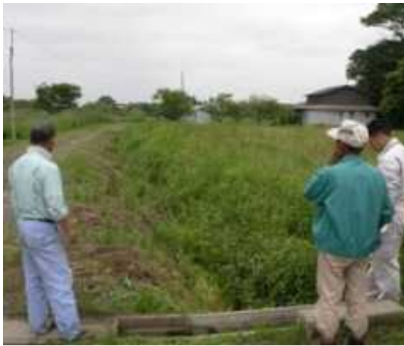
水路の点検作業
