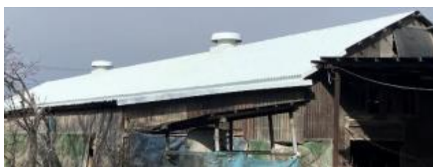
写真6 耐久性が10年程度の遮熱資材を塗布した牛舎屋根
