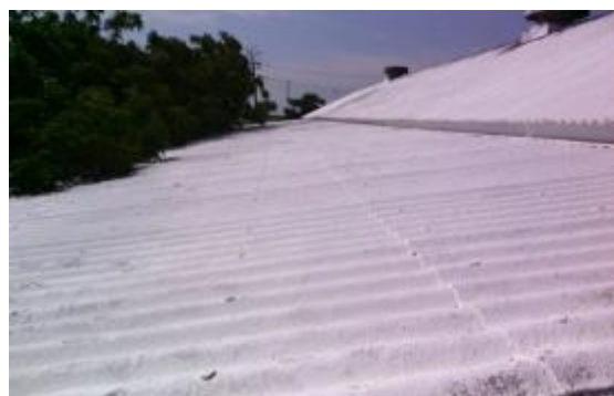
写真5 石灰乳剤を塗布した牛舎屋根
