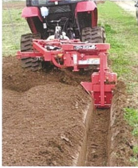
PTO式溝切機による明きよ施工
