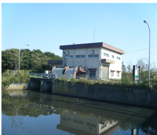
<野田排水機場>
