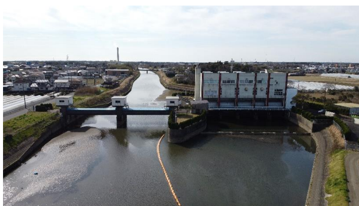
<新川用排水機場>
