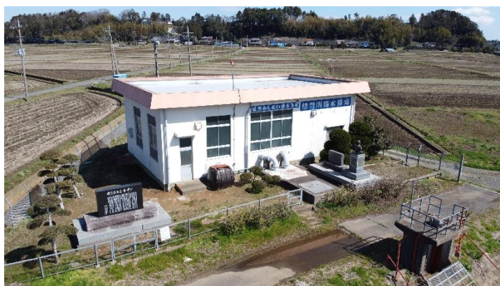
<借当川揚水機場>
