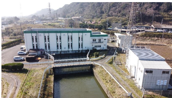
<笹川揚水機場>
