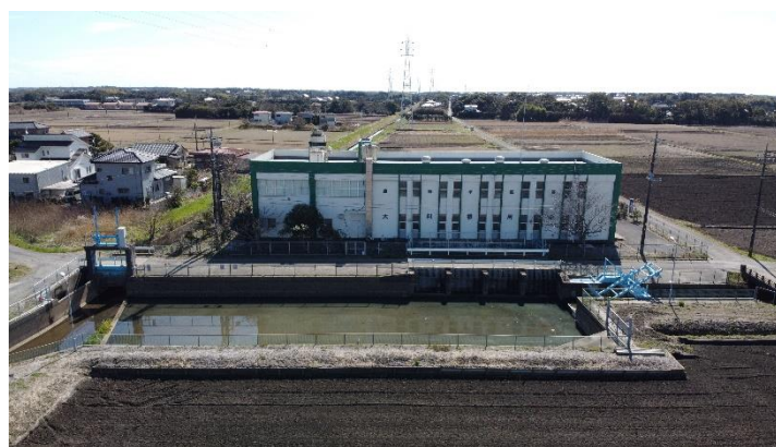
<新宿揚水機場>
