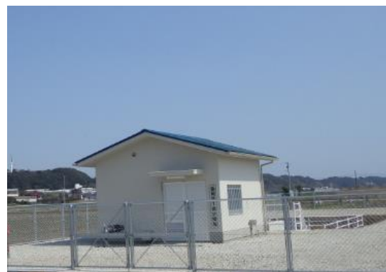
<用水を安定供給する揚水機場>
