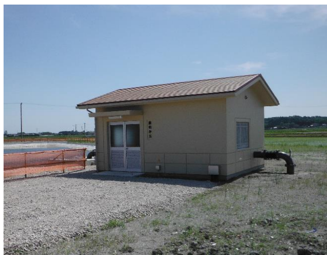
< 豊和 第5揚水機場 >
