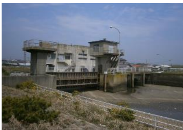
<新堀川排水機場>
