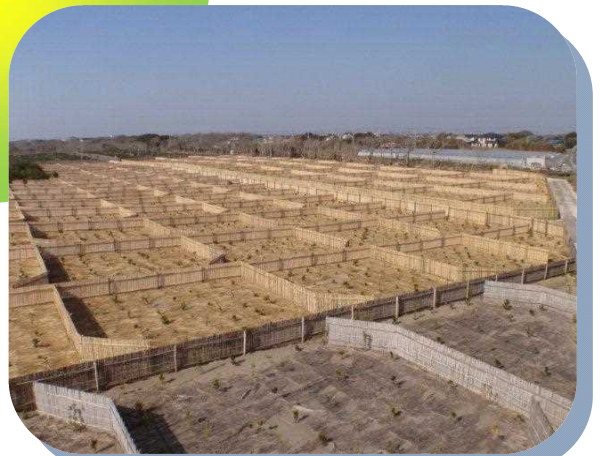
保安林緊急改良工事
