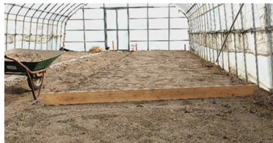
写真4 水系に沿って貫板を引き土の均平をとる
