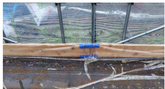
写真8 (改善案) ハウスパッカーによる農ビの固定
