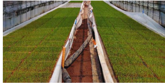
写真6 温水チューブ(黒色)がこぼれた状態で 角材や足場パイプ等で止水した。
