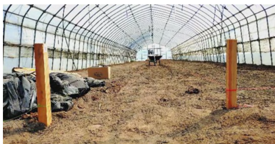
写真3 水系による水平出し
