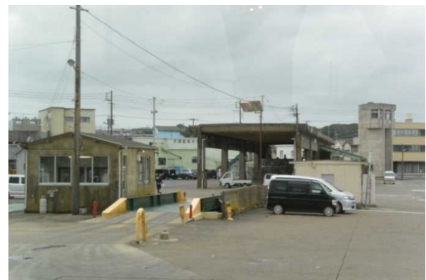
トラックスケール(車ごと積載した魚の重量を測る秤)
