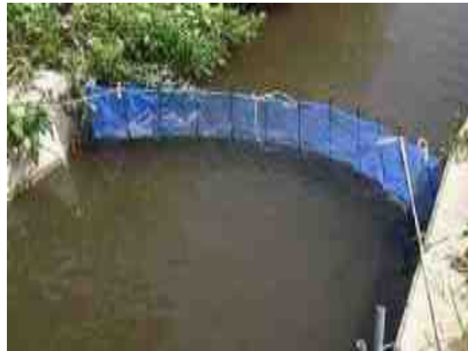
流出防止を目的とした網の設置例
