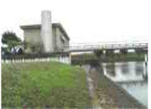
排水機場の法面での生育状況
