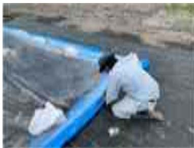
② 盛土の被覆と密閉
