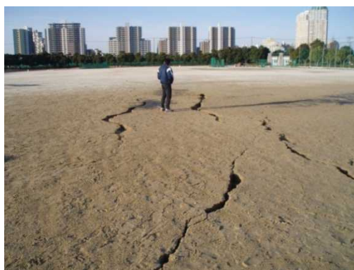
①グラウンド地割れ
