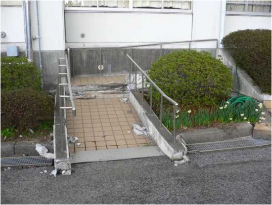
⑥玄関口のスロープ
