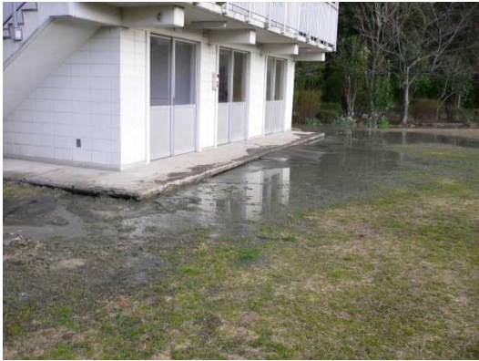
⑧部室棟付近
