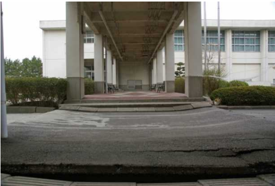
⑦通路付近
