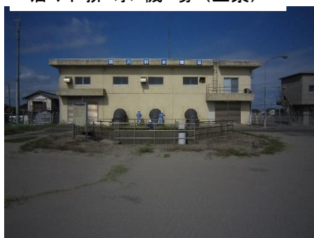
堀川排水機場（全景）
