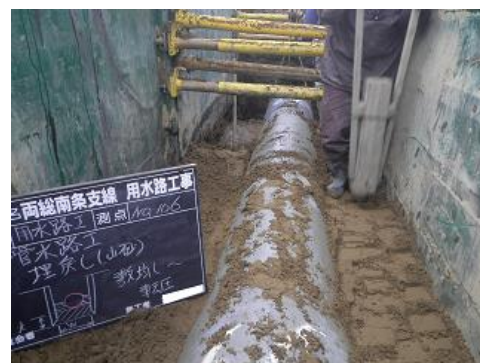
用水管布設状況（道路下）
