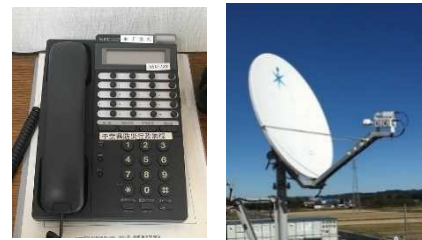
防災電話 パラボラアンテナ
