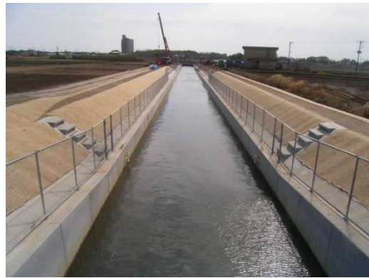
排水路の拡幅・かさ上げ
