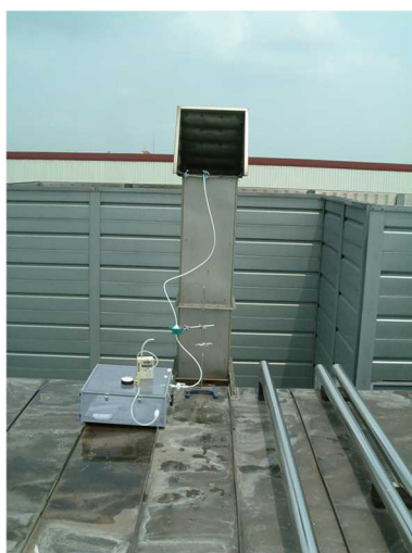
写真4 排気塔からガスを吸引
