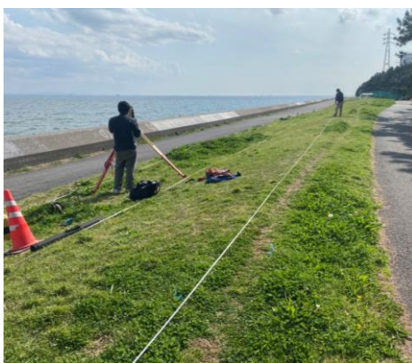
液状化による地盤の不等沈下地点での調査
