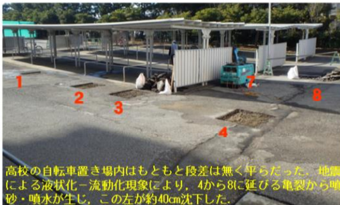
図 1 地震時の液状化一流動化により局所的に沈下した自転車置き場
