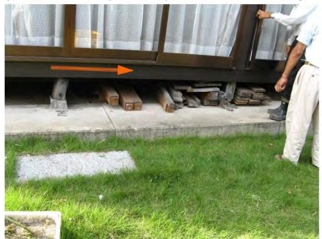
図 5 図 1 の Ph5 地点の写真 (家屋の左側の土台の下が隆起し, 家全体が右へ動いて歪み, 戸が閉まらなくなった。)
