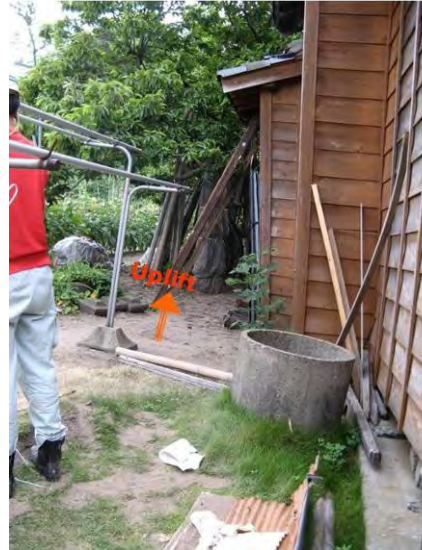
図 4 図 1 の Ph4 地点の写真 (隆起に伴い家屋が傾いている。)
