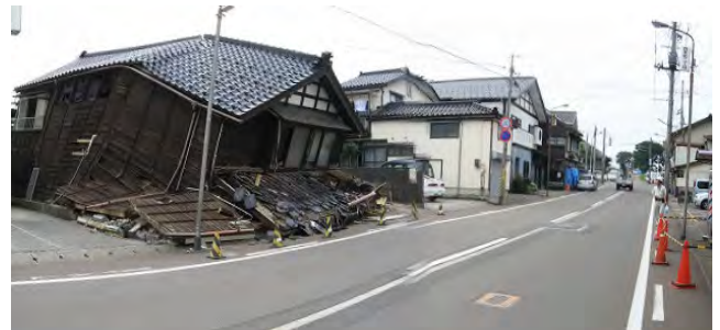
図9 柏崎市新橋での木造家屋の倒壊(北緯37度22分1秒, 東経138度32分58秒付近)
