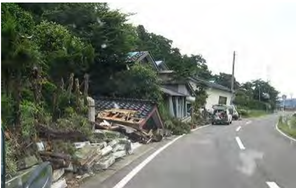
図6 西山町新保での木造家屋の倒壊(北緯37度26分43秒, 東経138度38分26秒付近)
